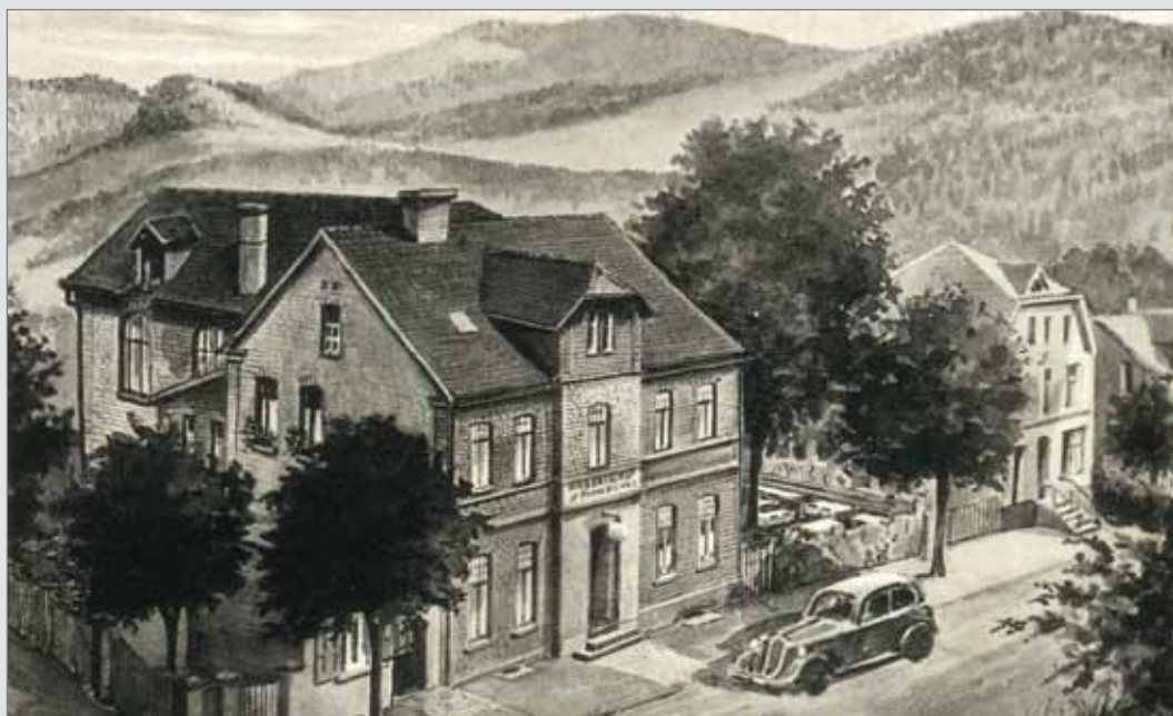
Der Müscheder Hubertushof mit Bäckerei wurde in den Jahren 1904-1905 von Franz Voss (1866-1949) erbaut. Im hinteren Bereich ist der großzügige Saaltrakt und an der Straßenseite hinter den Bäumen das im Jahr 1920 angebaute Ladenlokal zu erkennen. An der rechten Gebäudeseite lag die Gartenwirtschaft, die bereits vor dem Zweiten Weltkrieg aufgegeben wurde. Zum 500-jährigen Jubelfest der Müscheder Hubertusbruderschaft wurde sie zur Freude der Müscheder für einige Tage wieder aktiviert. Ansichtskarte Kunstanstalt Otto Walter, Meiningen i. Thür.
