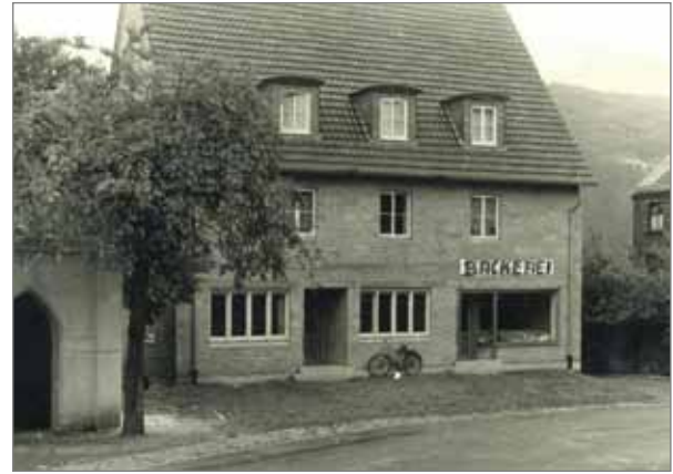
Neubau der Gaststätte und Bäckerei Hoffmann, Müschede, Krakeloh 19, mit vorzeitig eröffnetem Bäckerladen
