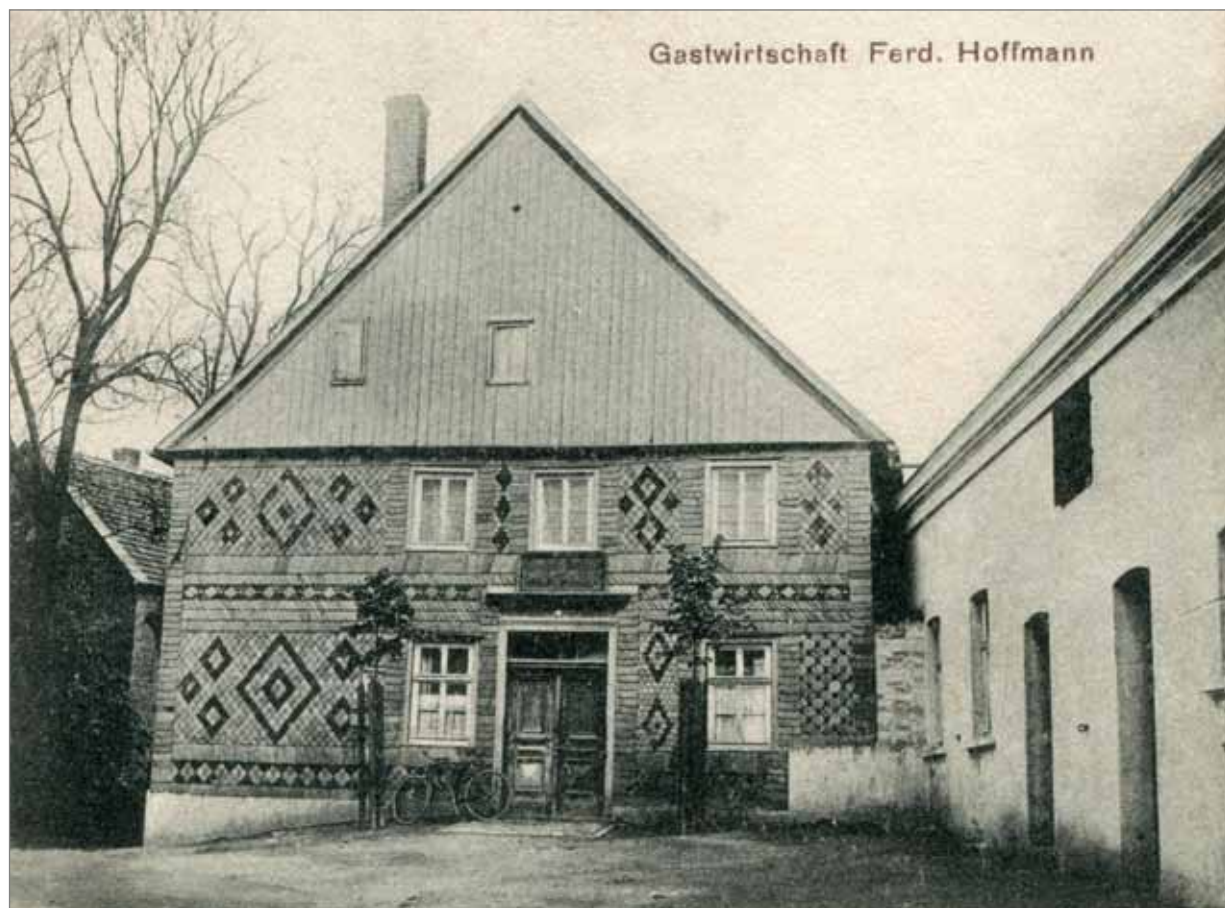
Gastwirtschaft „Zur Eule“ mit einer in der ersten Hälfte des 19. Jahrhunderts üblichen Zierschieferverkleidung der Eingangsfassade. Rechts im Bild der angebaute, 1906 bereits vorhandene Wirtschaftstrakt mit Backstube und den Kuh-, Schweine- und Pferdeställen. Ansichtskarte nach 1906, Verlag A. Habel, Hüsten
