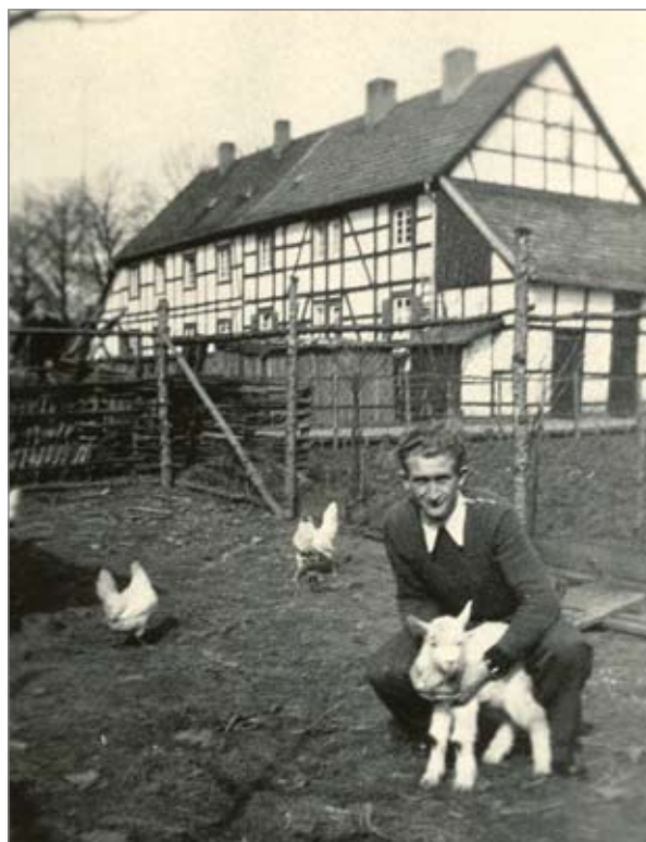
Fritz Oberg in seinem Garten in Müschede an der Grabenstraße. Im Hintergrund die Rückansicht des Hammerhauses an der Rönkhauser Straße, Ecke Grabenstraße. Im Jahr 1986 wurde es abgerissen.
