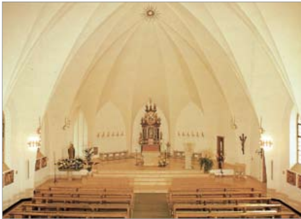
Die statischen Kräfte werden sichtbar in den Untergrund geleitet. Das Gewölbe steht auf dem Kirchenboden. Kath. Pfarrkirche St.-Antonius-Einsiedler in Langscheid von 1932. Architekt: Karl Wibbe, Hamm; Ansichtskarte, erschienen im Verlag Jos. Grobbel KG, Fredeburg, Original: Ortsarchiv Müschede (OAM).
