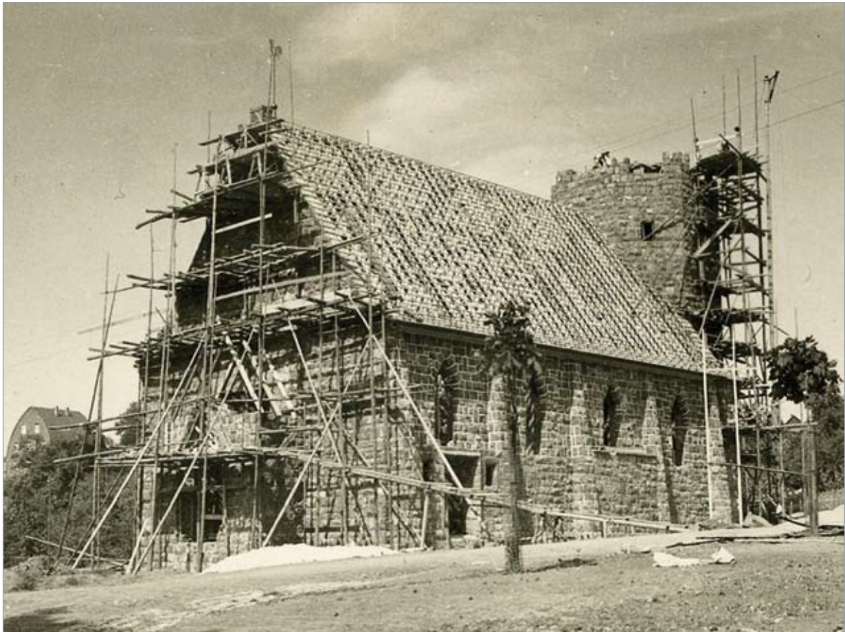
Der Kirchenbau nimmt Formen an. Die Dachdeckerfirma Engel aus Hüsten hat die Dachfläche bereits eingelattet. Der Eingangsvorbau ist gerichtet, und der Turm steht kurz vor der Vollendung. Original: Ortsarchiv Müschede (OAM).
