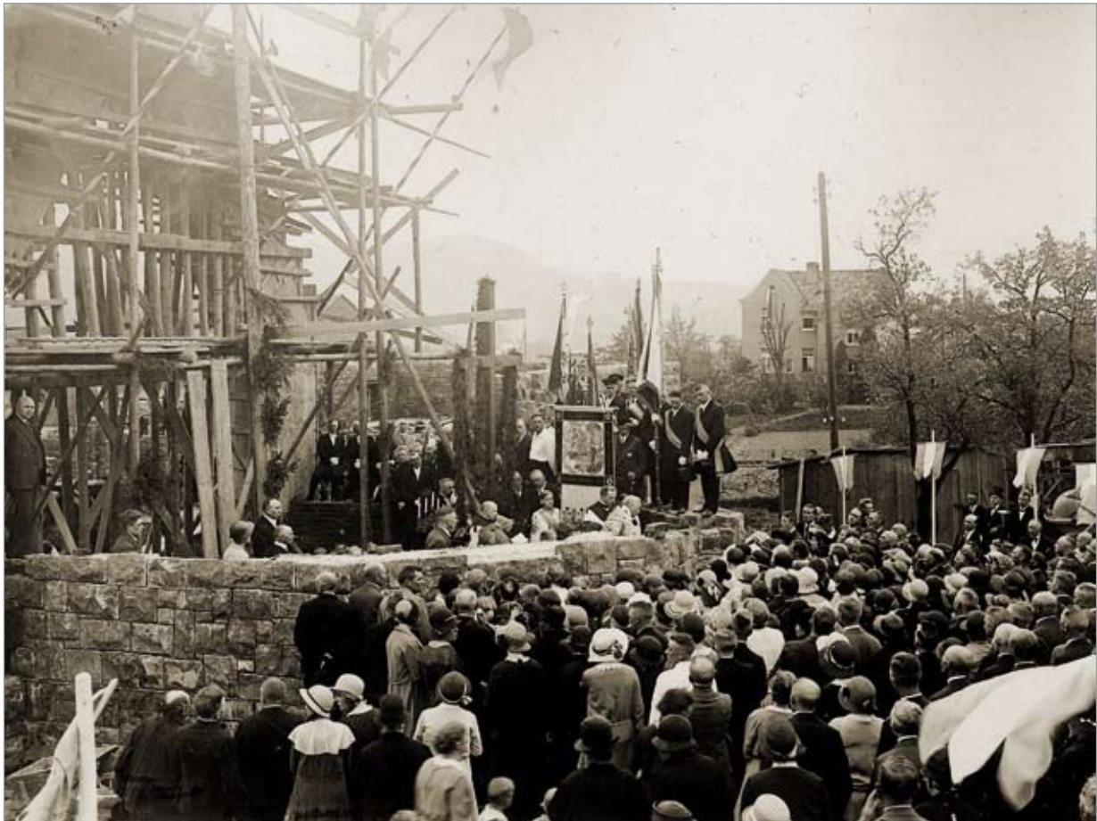
Feierliche Grundsteinlegung am Pfingstmontag, 16.5.1932. Links im Bild der eingeschaltete Chorabschluss - die "Eisenbetonarbeiten" wurden von der Firma Klinkmann in Hüsten ausgeführt. Original: Ortsarchiv Müschede (OAM).
